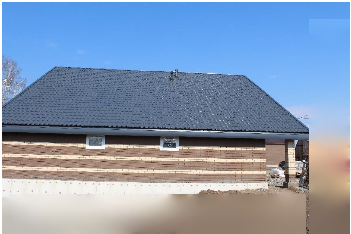
Фото 3. Общий вид здания по оси 1
