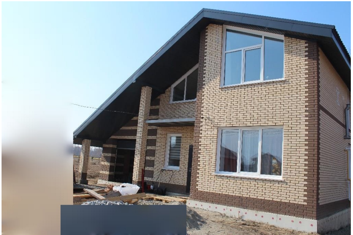
Фото 1. Общий вид здания по оси А
