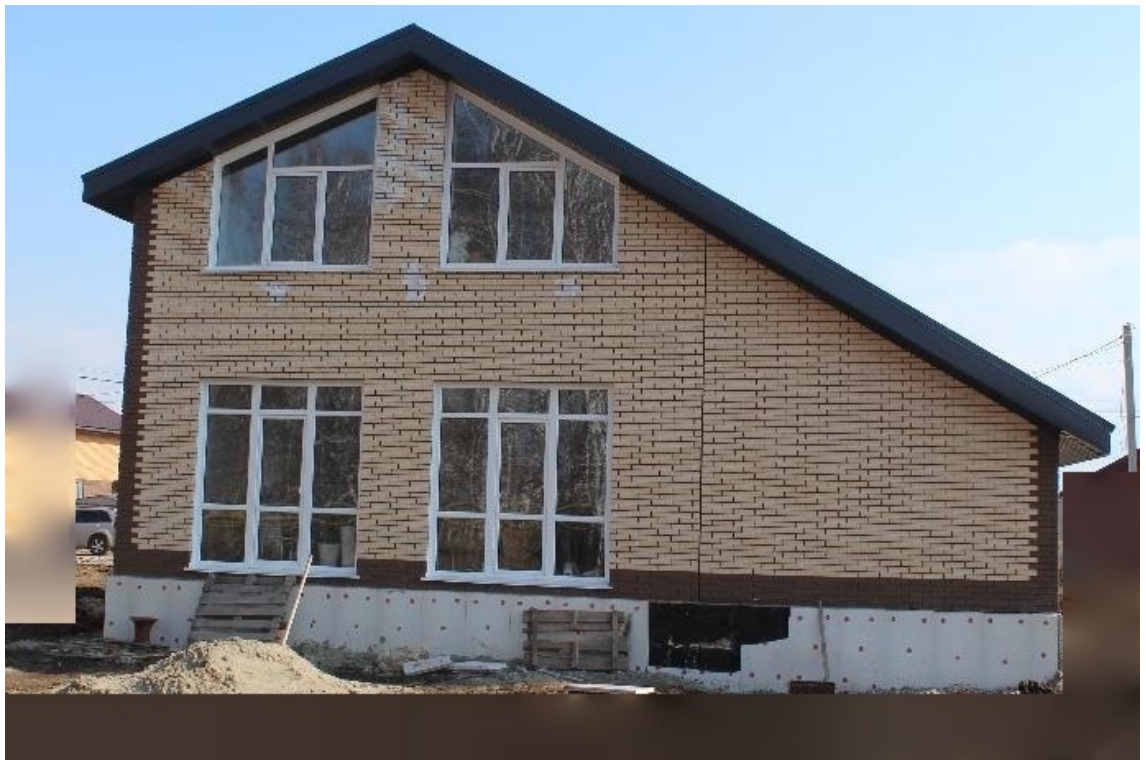
Фото 2. Общий вид здания по оси Д
